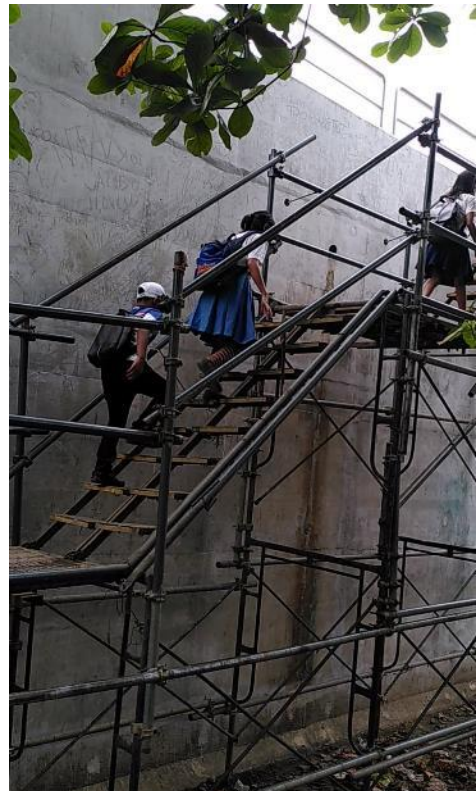
Der Schulweg führt über die riesige Damm-Mauer
